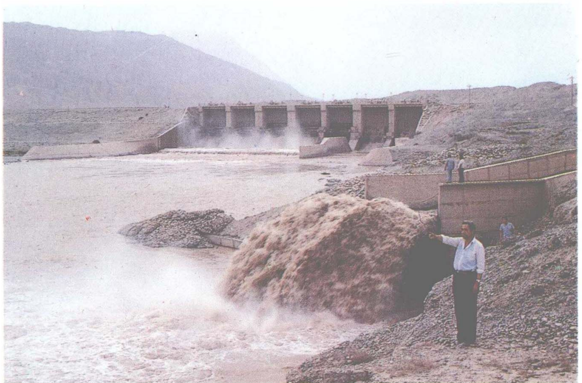
克孜河喀什一级电站拦河闸
