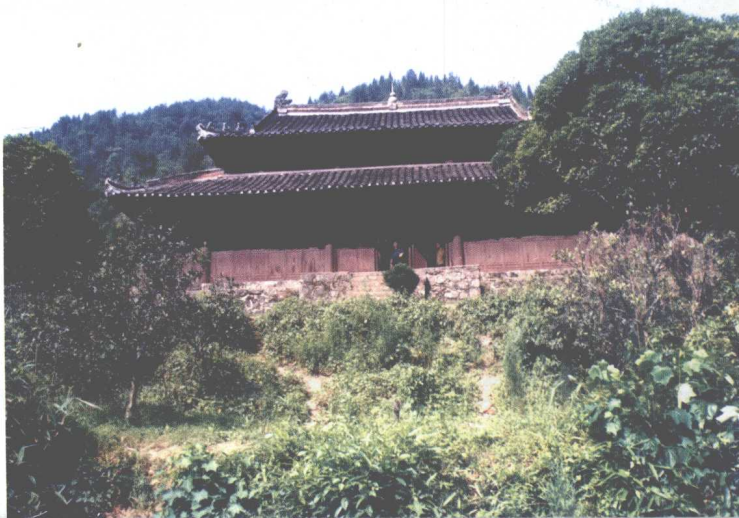
图-18 永顺 溪州土司治所大平 山麓祖师殿,始建 于后晋天福年间, 距今已有千余年历 史,与永顺溪州土 司一样古老……
