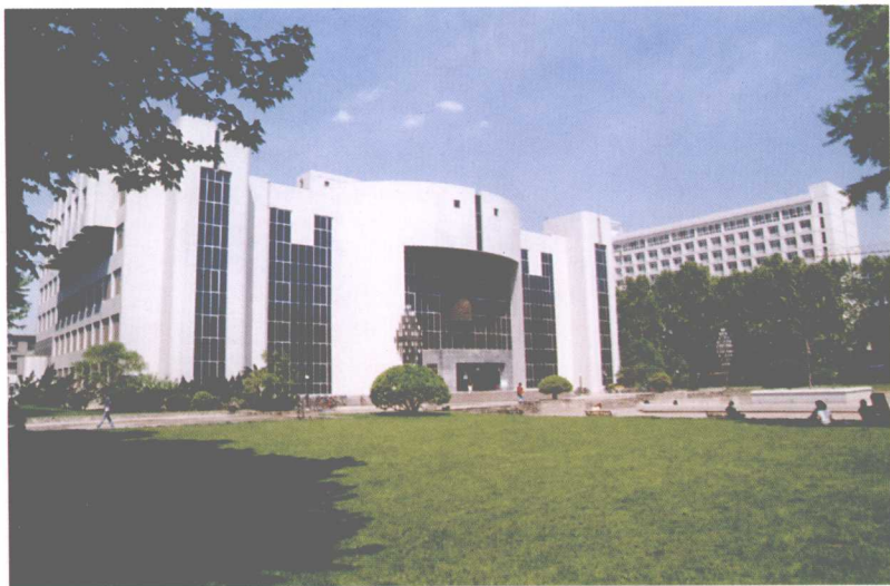
雄伟壮观的现代化建筑——图书馆东馆
