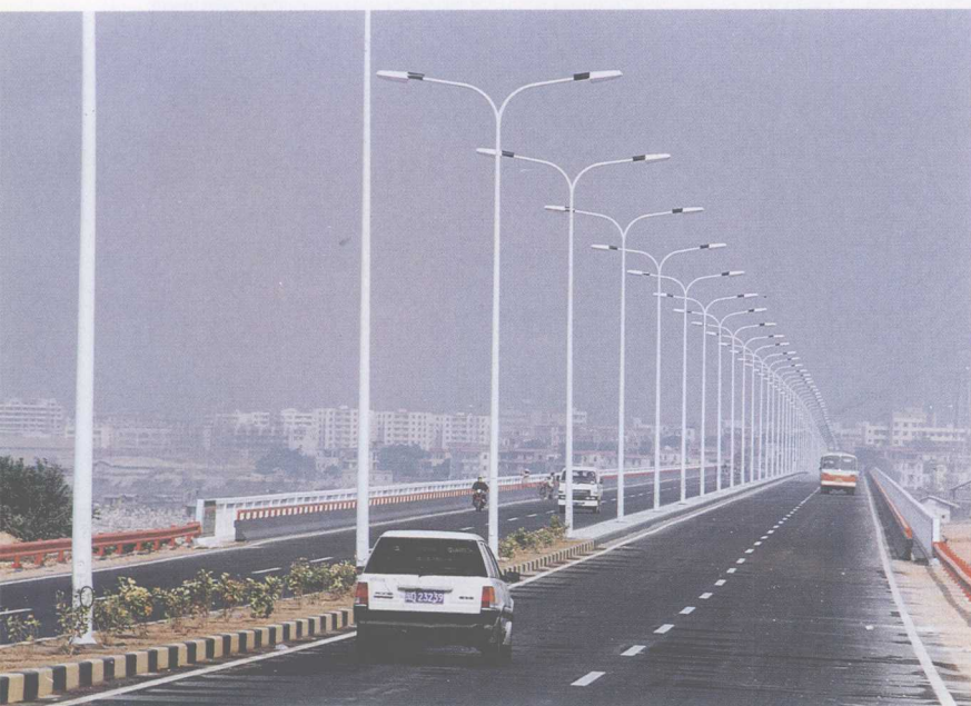
于1996年竣工并投入使用的新阳大桥,连接海沧和杏林,总投资1.2亿,全长1600米,宽28米。
