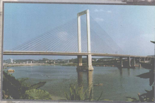
南宁市白沙大桥全长2604米，主跨122.5米，是独塔双索面斜拉桥。1995年1月通车。工程质量优良
