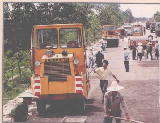
实施“八五”国家科研项目碾压砼路面施工现场
