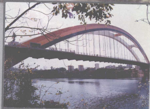
邕宁邕江大桥全长458.4米，主跨312米，是钢骨架钢筋混凝土中承式拱桥。1996年9月通车
