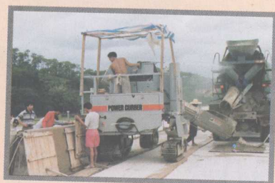
使用滑模摊铺机浇注中间分隔带
