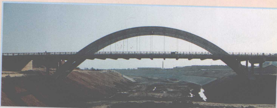
已建成的上引航道交通桥及 在建的上引航道
