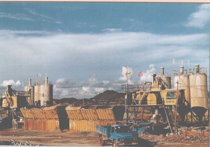
水泥砼拌和设备 ELBH-60 型拌和楼
