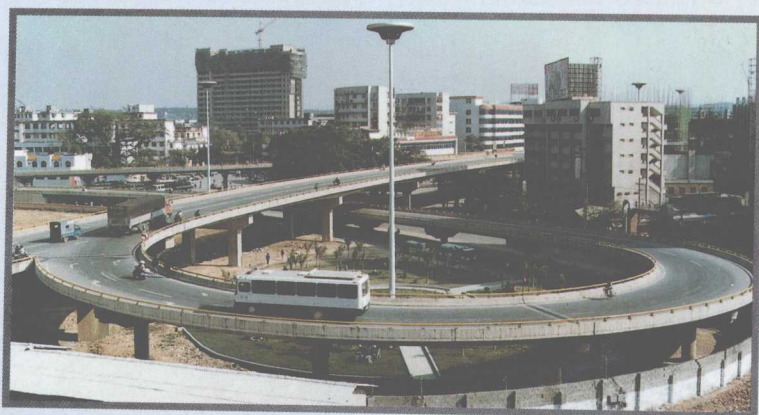
白沙大桥北岸引桥
