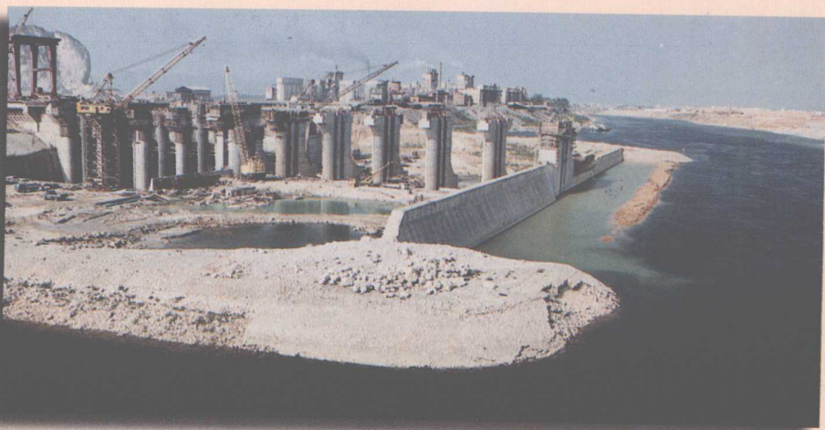
建设中的西江二期工程发电站
