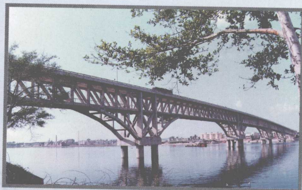
峦城大桥全长785.5米，主跨 60 + 3 \times 100 + 60 米，是预应力钢筋混凝土连续刚桁双层桥面公路桥。1995年6月通车。工程质量优良
