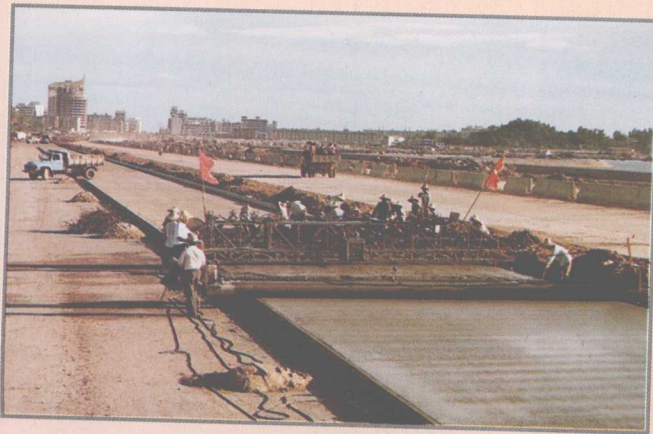
钦防高速公路水泥砼路面振动整平机施工现场
