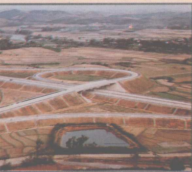
桂柳高速公路鹿寨互通式立交
