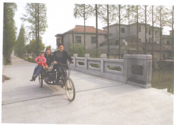
改造后的农村桥梁
