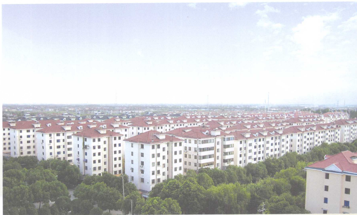
完成平改坡工程后的南桥镇居民房
