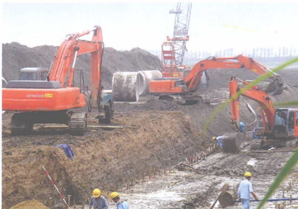
污水管网建设
