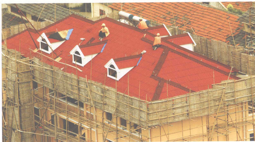
平改坡工程施工现场
