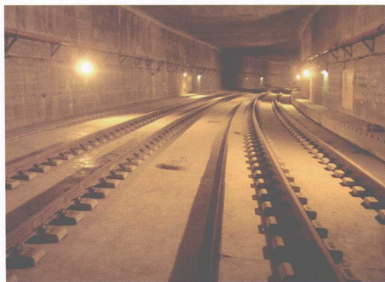
图 1—6 弹性支承块式无砟轨道
