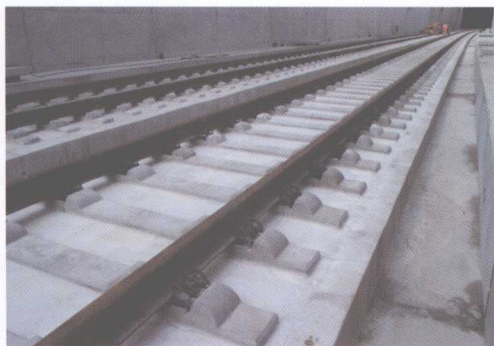
图 1—1 Rheda 型传统型无砟轨道
