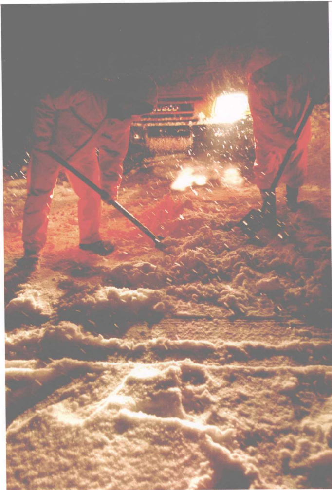
2008年1月25日凌晨，江西省公路局京福高速公路温沙管理处工程队员连续工作18个多小时，使路面全部疏通。通过积极动员组织、制定科学抢险措施，福银高速温沙段全线在春节期间基本保证了通畅
