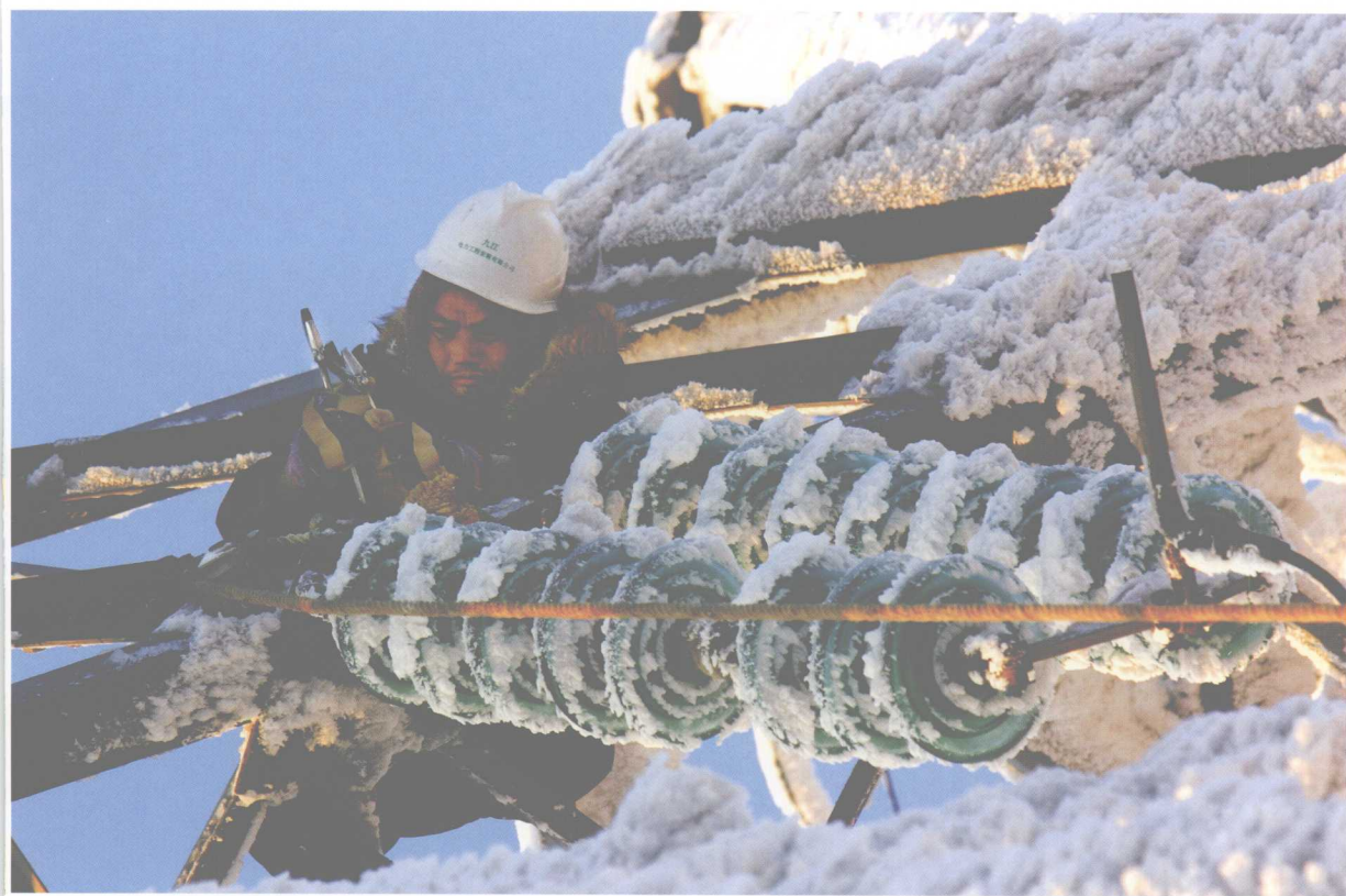
2008年1月29日凌晨4时，江西九江，妙庐线49号塔110千伏高压线因覆冰达100毫米而断线，九江市供电公司抢修人员在海拔1200米的雪峰激战7小时，于晚上10时修复断损线路
