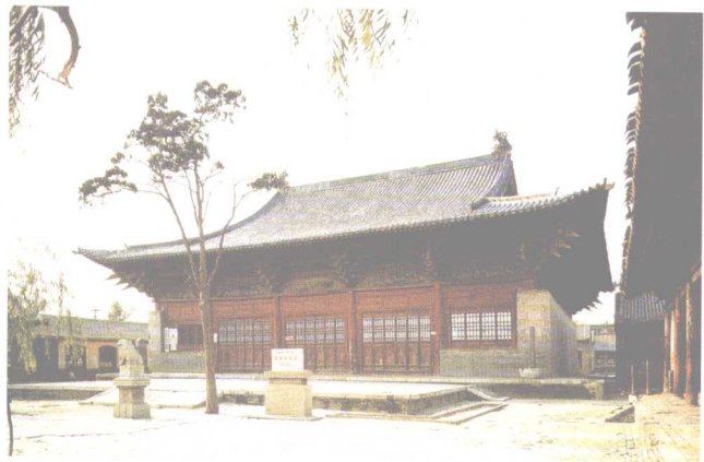
图1-4 中国古典建筑的大屋顶和屋檐下的斗拱
