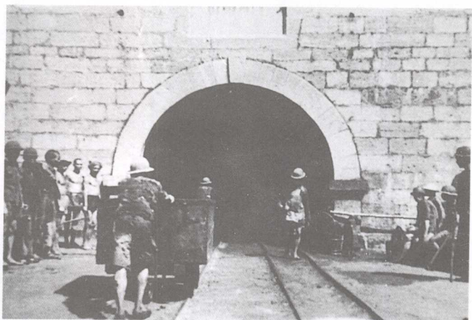
△ 40 年代建成的天府煤矿矿井洞口。
