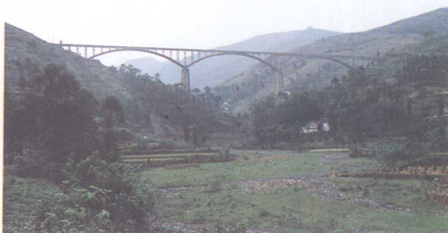
△ 江北县 1980 年 3 月建成胜天水库小桥渡槽。
