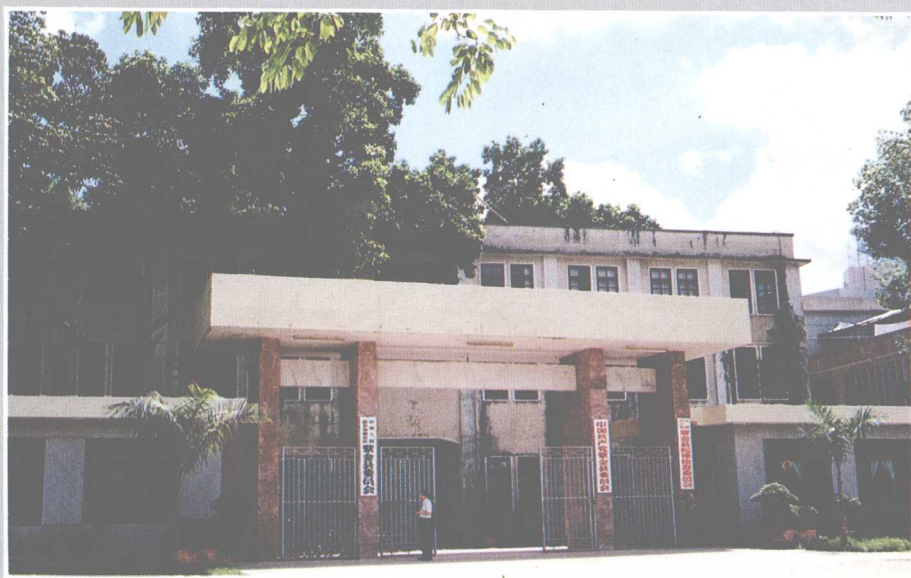
◀ 中共紫金县委办公楼
