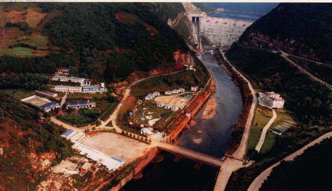
柴石滩水库坝后全景
