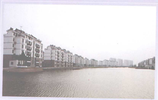
建设中的钢村嘉园
