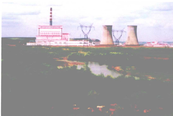
伊敏煤电公司电厂
