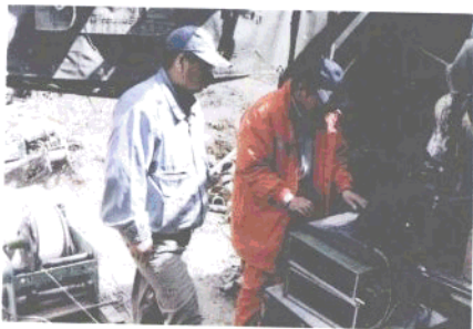
图为我技术人员在兰州至武威二线铁路乌鞘岭隧道做综合 测井
