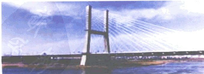
由公司承担岩土工程勘查的兰州银滩黄河大桥
