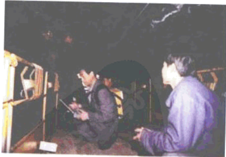
图为技术人员在内江至昆明铁路某隧道做检测
