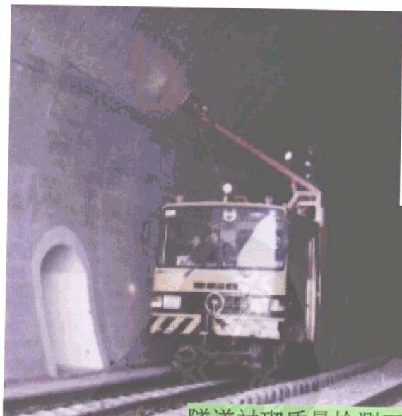
隧道衬砌质量检测工作场景
