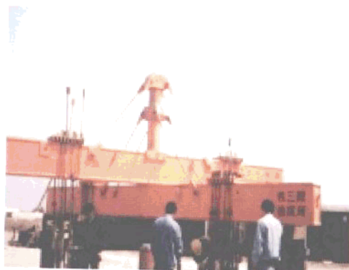
基桩静载荷试验
