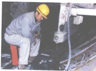
图为技术人员在西安至安康铁路秦岭特长隧道做超前 预报
