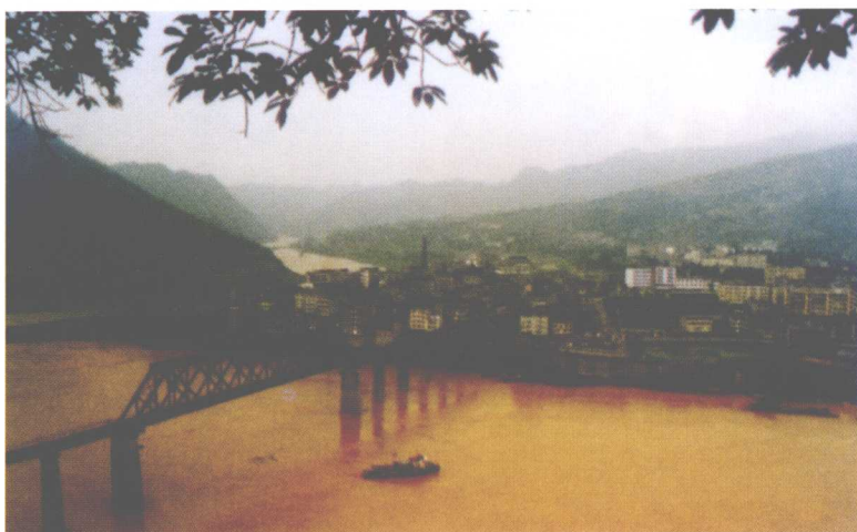
内昆铁路金沙江大桥
