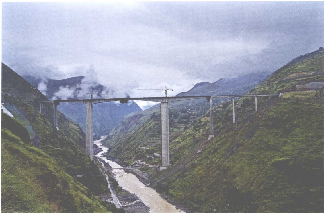
昆(明)水(富)公路江底特大桥
