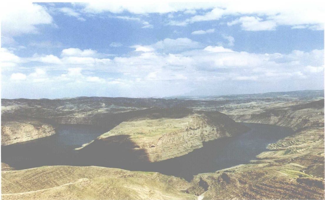
万家寨水利枢纽库区弯道
