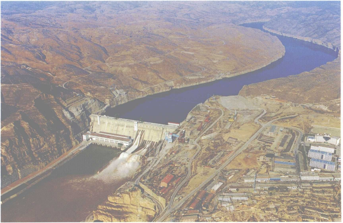
万家寨水利枢纽坝址全景
