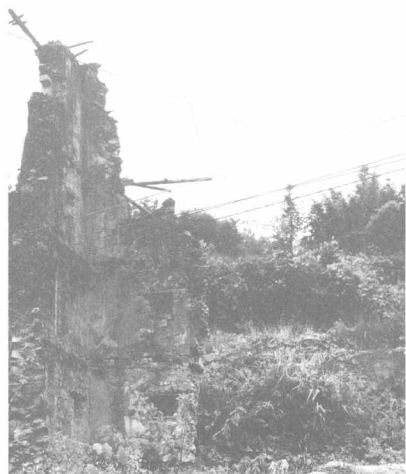
上坪茶活炮楼残墙断垣。1933年8月兴龙苏区军民把守炮楼，与敌激战三昼夜，最后18勇士坚贞不屈，葬身火海，与炮楼共存亡。
