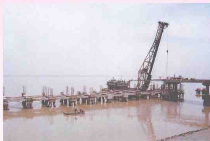
上虞港一期3000吨级码头主体工程
