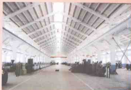
绍兴市电缆厂生产的物理高发泡射频同轴电缆,经电子部信息传输线产品质量监督检测中心测试,各项性能指标优于IEC标准,并已取得广电系统入网认定证书。该图为物理发泡电缆生产车间。
