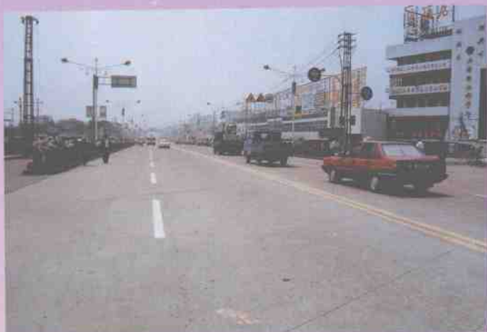
拓宽成32米的104国道市区西大门公路
