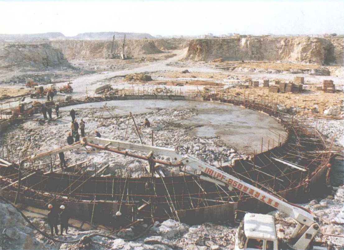
▲秦山核电站二期工程于1996年6月开工，秦山二期为装机容量 2 \times 60 万千瓦的商用核电站。图为二期工程一号反应堆工地 张录摄
