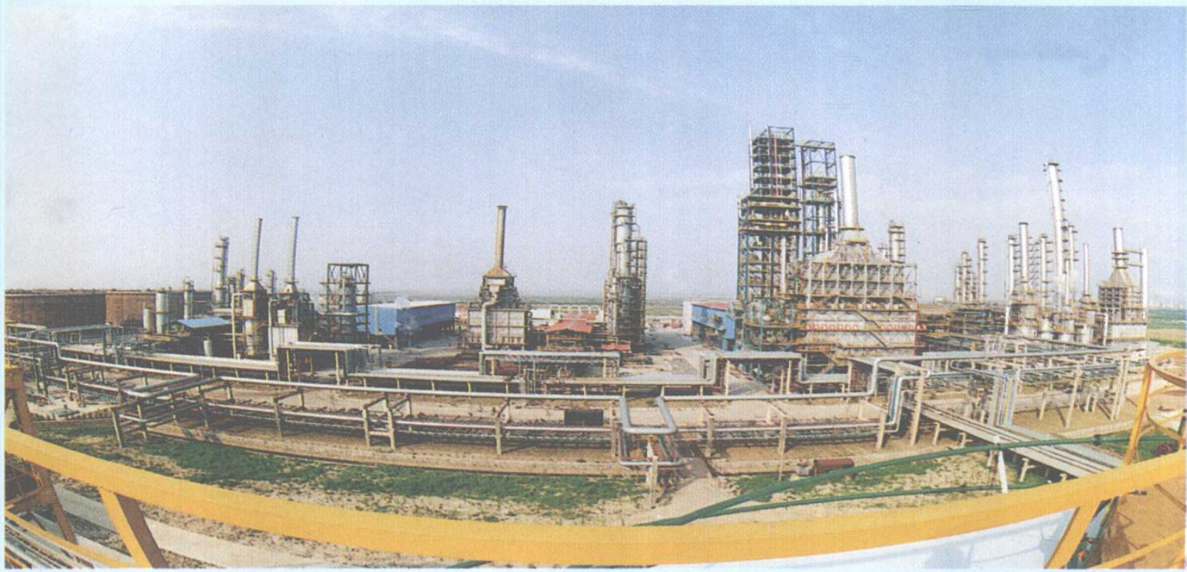
◀特大型炼油化工联合企业——镇海炼化股份有限公司经过20多年的建设，目前已拥有年加工原油800万吨、年产尿素60万吨的生产能力，1996年加工原油600多万吨，实现利税17.72亿元 龚国荣摄
