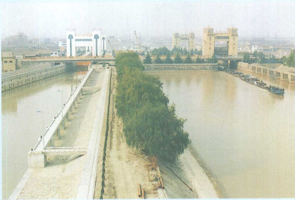
▲杭州三堡二线船闸建成通航，它使三堡船闸的年过闸能力达到千万吨以上 宋初华摄
