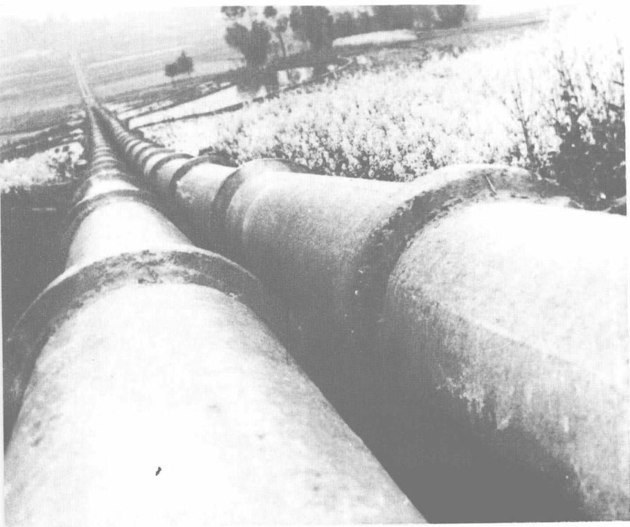
◀ 宝石水库甘棠龙王坝倒虹管
