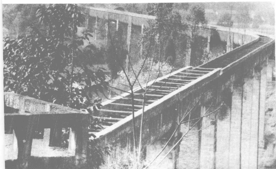
◀ 宝石水库观音桥渡槽
