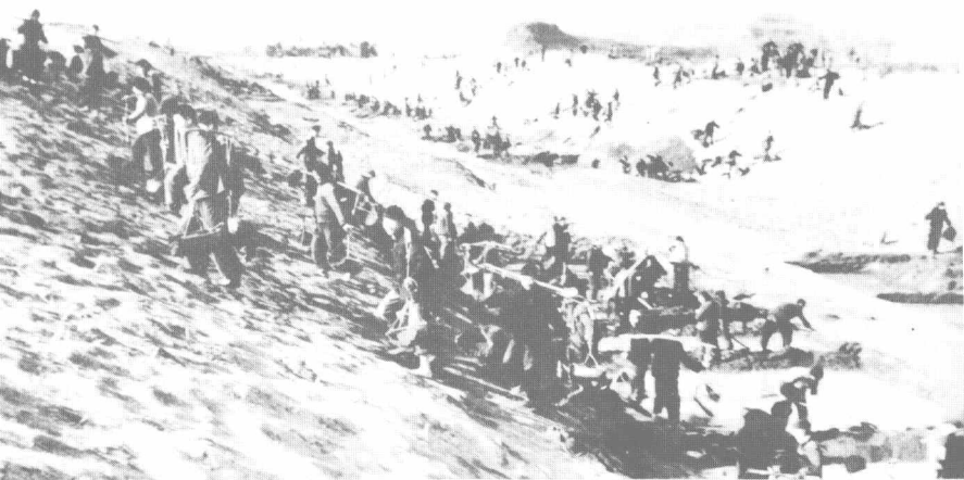
◀ 新宁河改造工程一角
