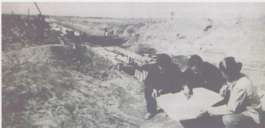
1962年3月技术人员进行唐徕渠排水大涵洞施工
