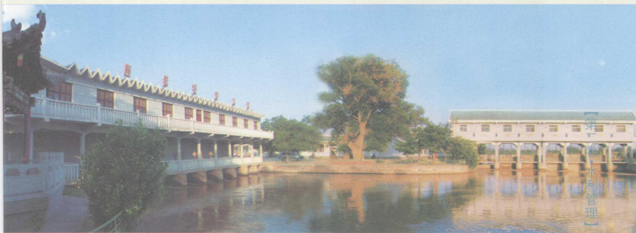
唐徕渠、惠汉干渠进水闸
