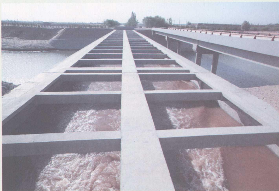
2007 年新建的二农场渠跨爱伊河渡槽
