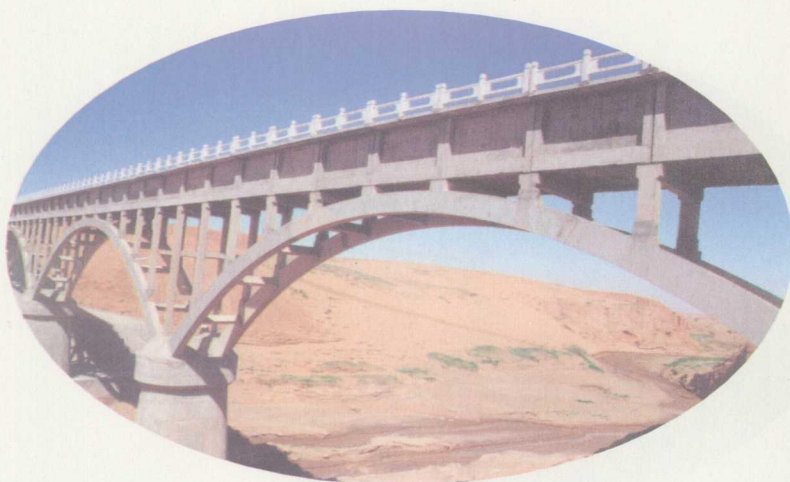
红寺堡扬水工程红柳沟渡槽
