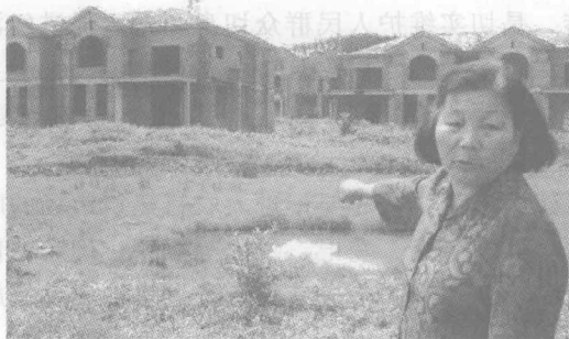
图1-1 浙江永康“烂尾楼”
