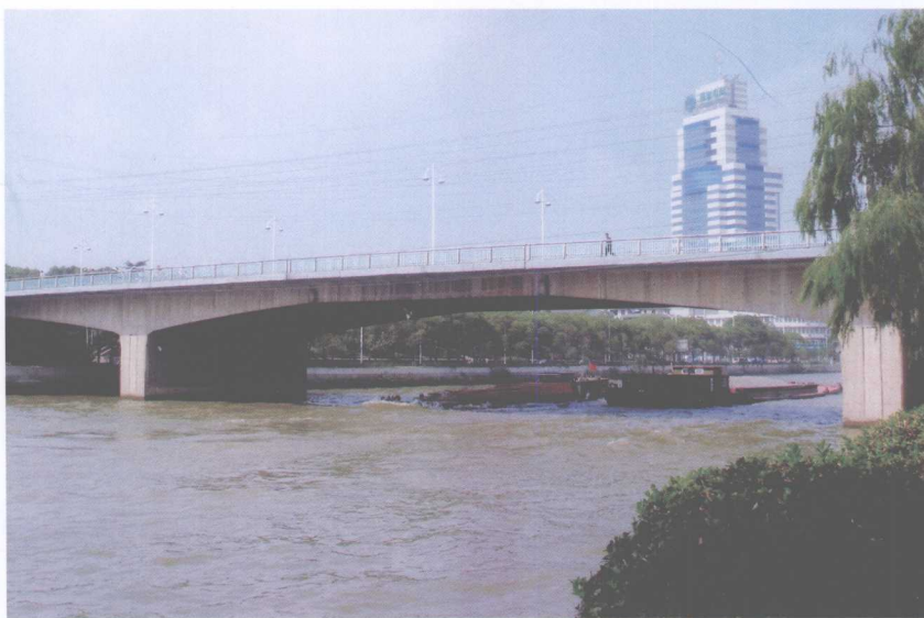
无锡梁溪大桥
