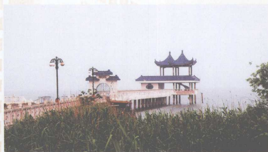
无锡某单位自备水厂取水设施
