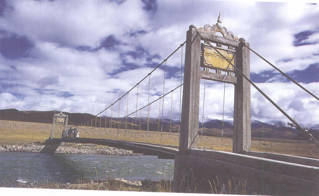
怒江在西藏的最大支流——玉曲河上的桥梁
