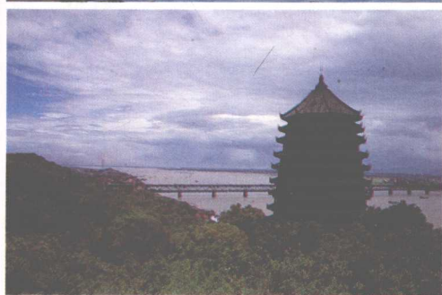
◀ 六和塔与钱塘江大桥
