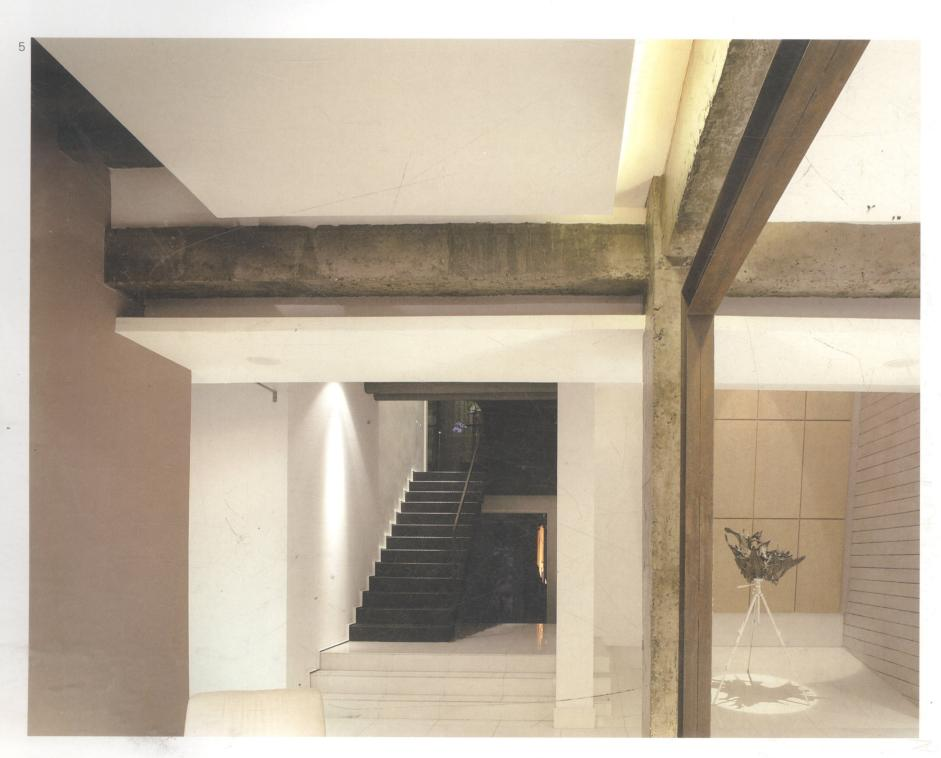
5 钢筋混凝土的梁柱所在是原来承重墙 的位置, 重新浇筑之后干脆如实裸露着, 再加之平行槽钢折框的叠合, 成为纯白 空间里的指向性色带和细致整体中的一 点狂野。
