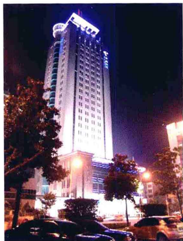
电信大厦（杨绍先摄）
