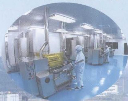
小容量注射剂生产线
