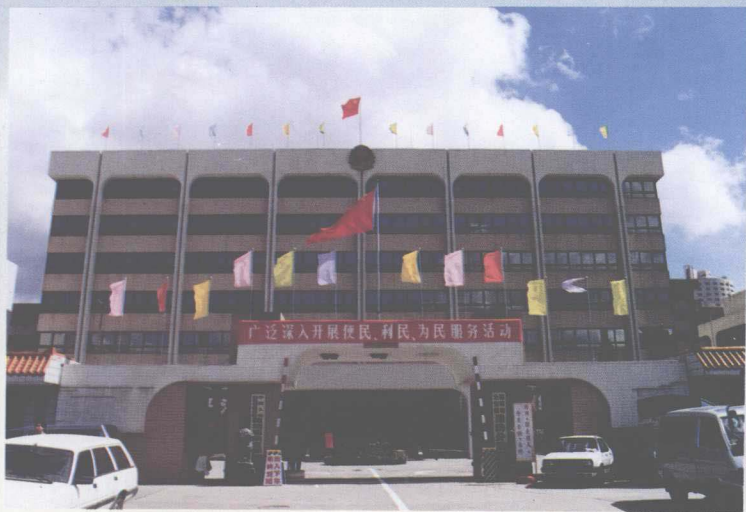
边防分局大楼
