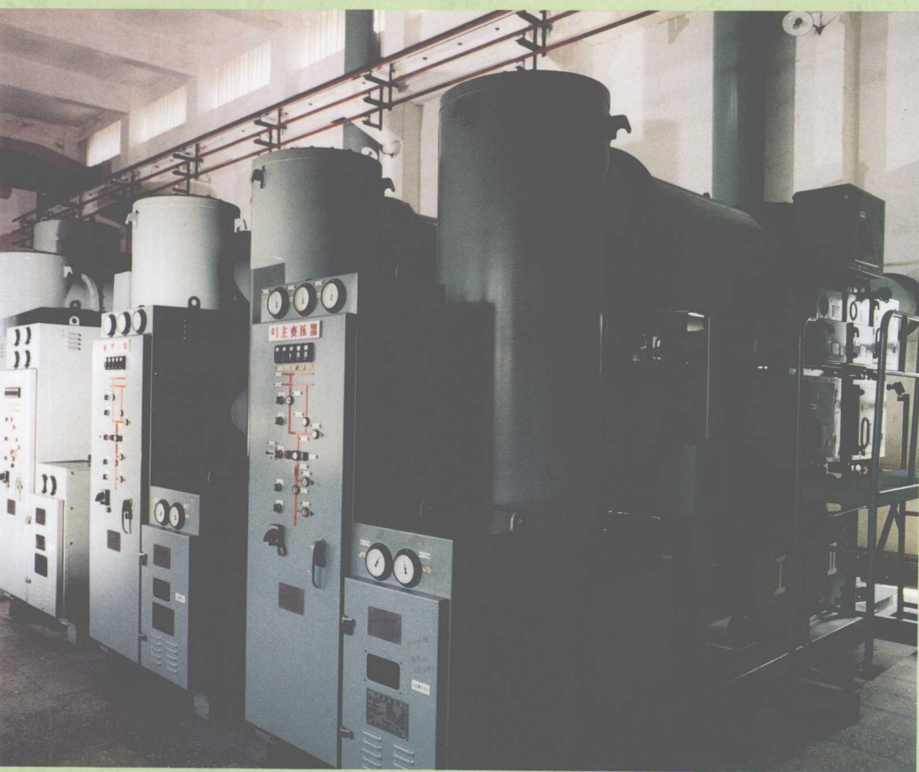
1984 年在深圳首次使用的六氟化硫组合电器开关
