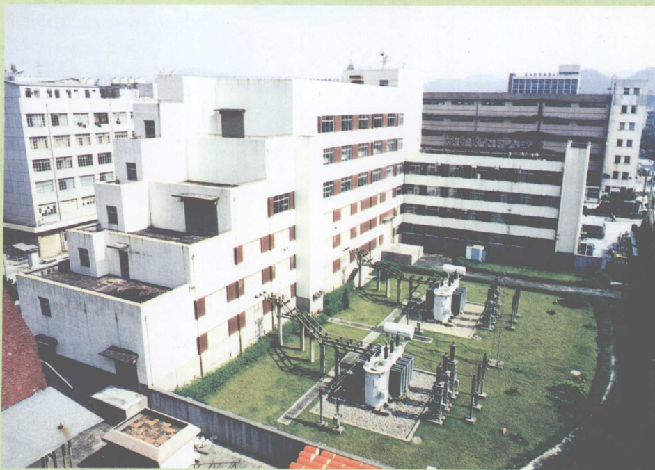
无人值班的变电站——110 千伏中航变电站
