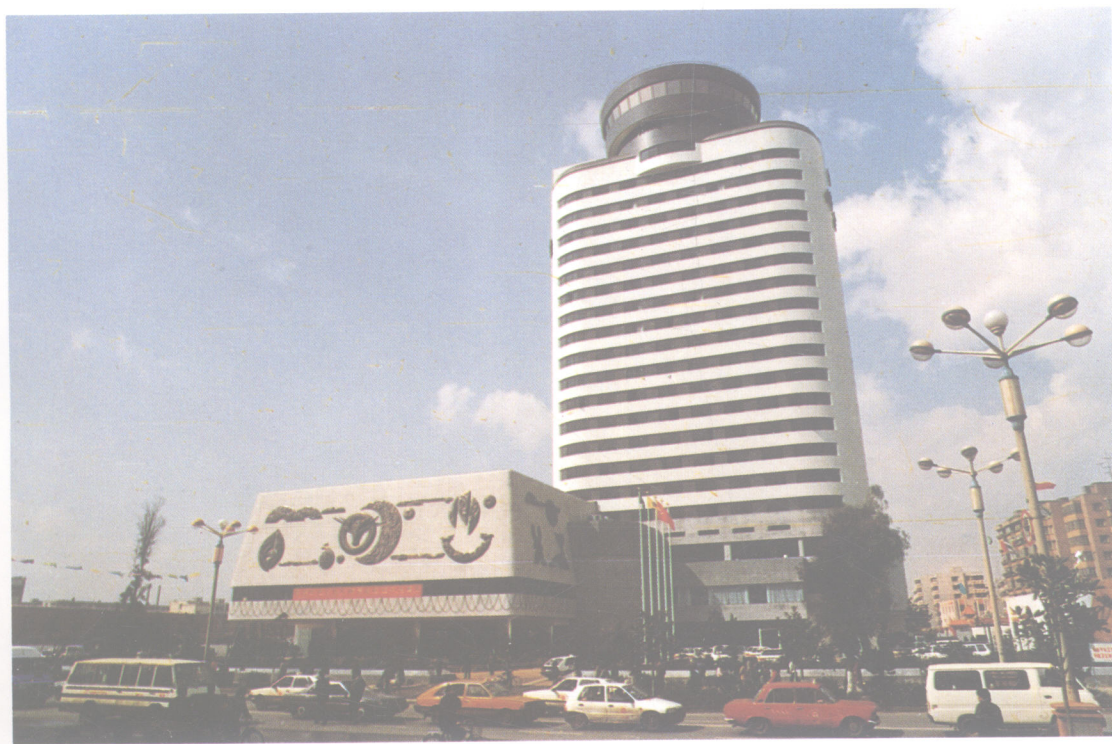
昆明锦华大酒店一期工程全景
