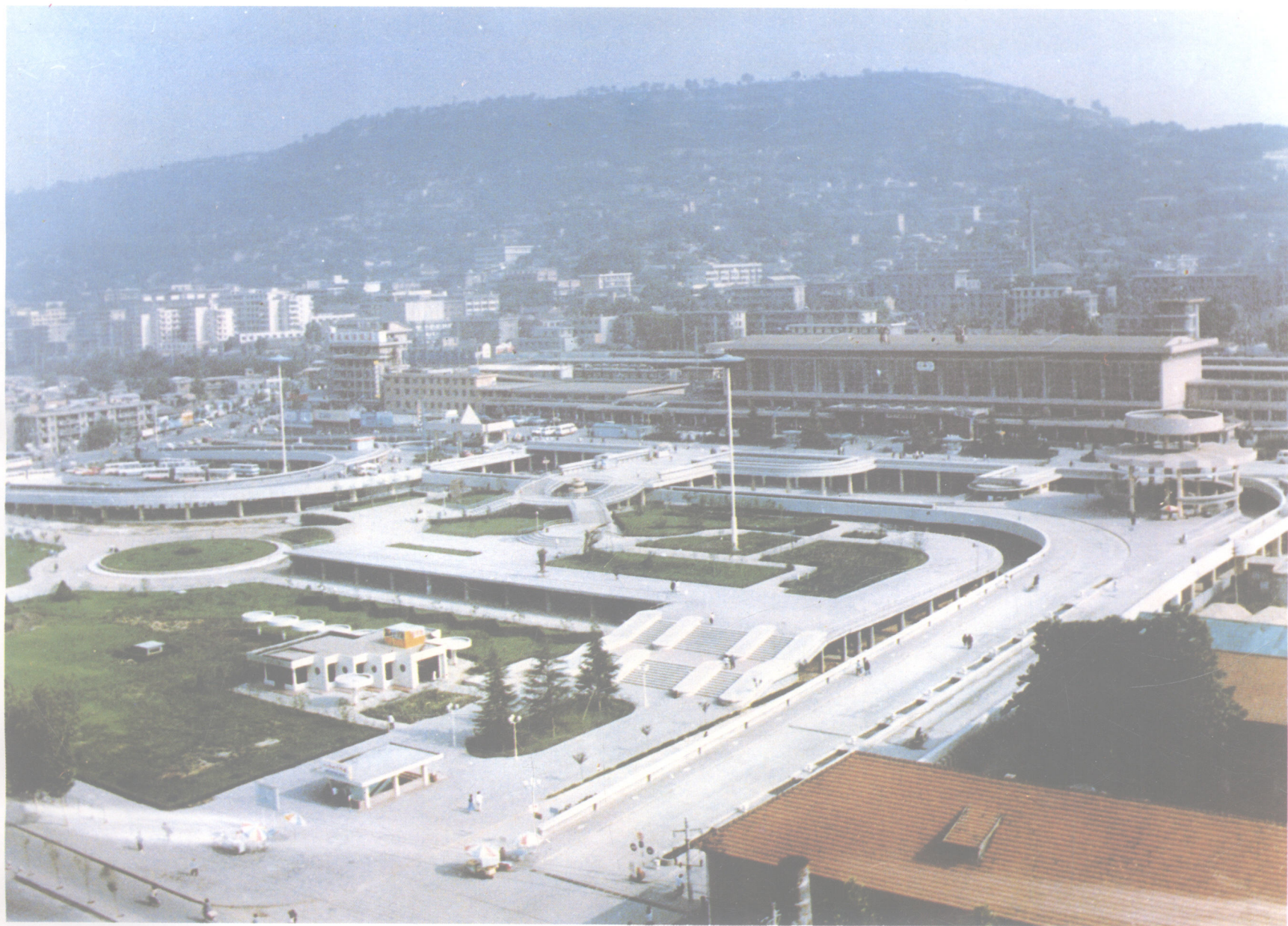
宝鸡火车站广场工程全景
