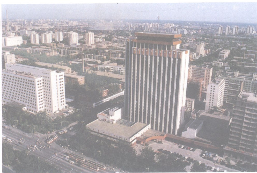
京西宾馆东楼
