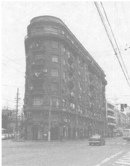
这座伫立在上海淮海中路上被叫做“武康大楼”的建筑,解放前叫“诺曼底公寓”,它暗红色的身躯,像一艘巨轮见证了上海西区的一切变化。余庆路与天平路在这里交汇,它是个六岔路口,与之交汇的还有兴国路、武康路,是我们中小学同学相当熟悉的地方,很多同学的家就在它的附近。
