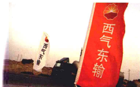
西气东输冀宁管道准备开工建设。
