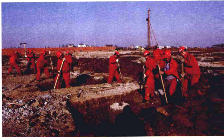
西气东输金坛储气库输气干线工程在江苏开工。
