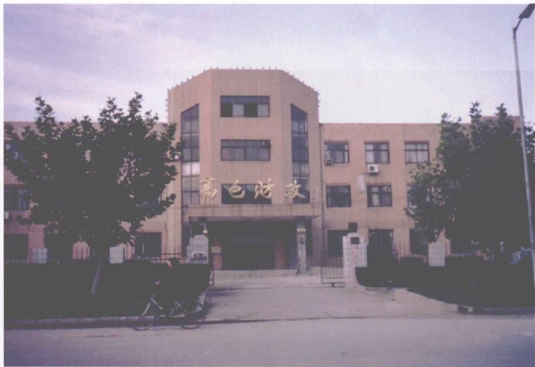
高邑县财政局办公大楼
