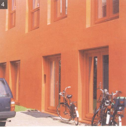
在奈梅亨市工艺学校的设计中所使用的那些空心块。那些门和窗户有着明晰轮廓的构件，并尽可能地没有细部。每一个构件（门、框架、安全设施）都具有一样的色彩（图4）。甚至连信箱也只是一条裂缝而已。像在希尔维苏姆的VPRO 别墅（见第110页）那样似乎是被随意地切割出的一个体块，其原先的意图是要展示那些混凝土楼板的毛面侧边，结果却让玻璃面夺了风头——这是一个让业主觉得过于危险的细部（图6）。而2000年世博会展馆的设计，包含了一个表露出概念的非常惊人的细部实例（图7）。在拥有树林的那个楼层上，沉重的木质树干代替了水泥柱子，这种结构上的解决办法完美地吻合了树林的形象。然而在代替柱子的树干顶部和底部，那些钢联结点却被明显地强调了出来。随着这些细部看起来几乎变成了独立性要素的特征，MVRDV建筑事务所似乎造就出了超现实主义画家马格利特的画作《这不是一支烟斗》的一个建筑版本。人们在这里看到的“树林”，实际上是一个“人造树林”。这就加强了建筑物和树林对第四层平面的影响，并使得人们明确理解了MVRDV建筑事务所的理念：自然，就是某种必须要加以建构的事物。
