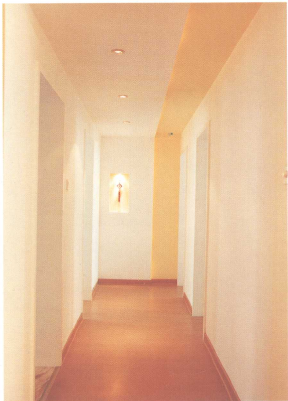
● 过道中顶与背景相连的一道柔黄很温暖。为掩饰中央空调的管道低的问题, 将过道顶设计成高低两层, 并与背景连成一体, 让人感觉是设计的需要。
