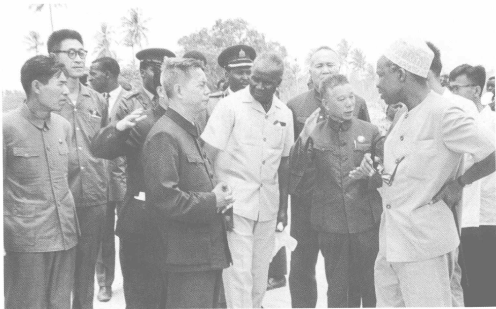
1970年10月26日,参加坦赞铁路开工典礼后,方毅(前右四)陪同尼雷尔总统(前右一)、卡翁达总统(前右三)一起视察铁路建设工地。
