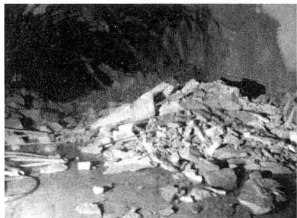
图 1.8 雅西路隧道出口局部岩爆
