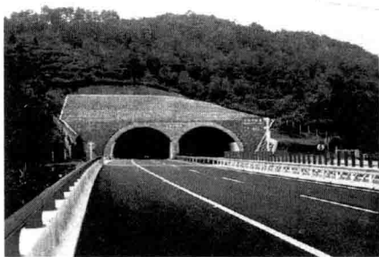
图 1.9 连拱隧道
