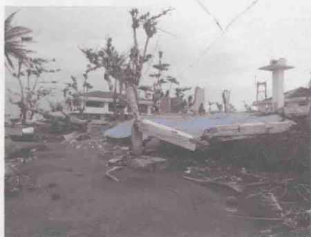
图 6 2013 年台风“海燕”对菲律宾的破坏（马兰 87 号自治区） 图 7 曼谷的交通堵塞（素坤逸路） 可以看到被冲蚀的钢筋混凝土房屋和地基（参见 3.4 节）。 一个十字路口的堵塞延伸到下一个十字路口（参见 2.5 节）。
