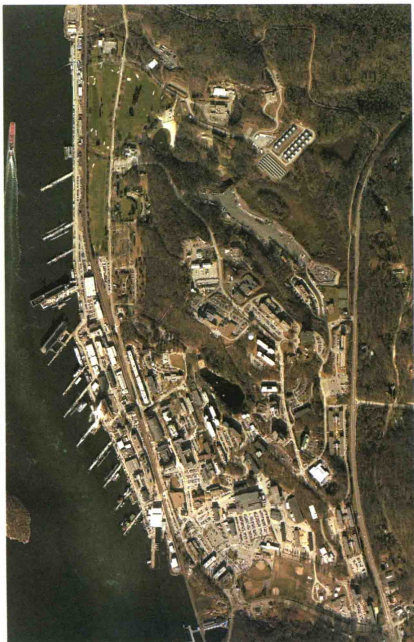
新伦敦核潜艇基地全景卫星照片(2011年左右)，可见海岸内的军舰停泊码头区，这片码头区共由12座栈桥码头组成，不包括基地最南部由“鹦鹉螺”号（SSN-571）核潜艇停泊的专用码头
