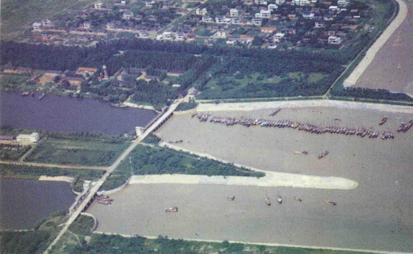
东台市梁垛闸(入海口)全貌
