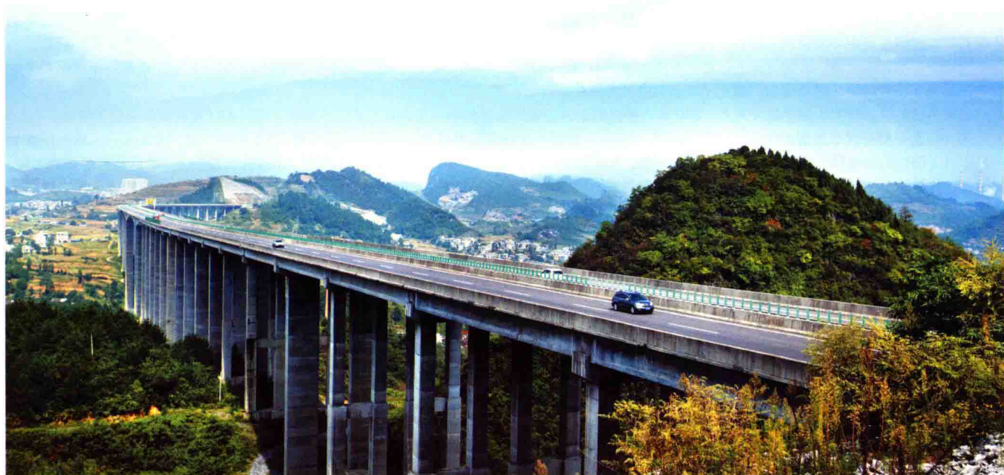
杭瑞高速金沙特大桥
