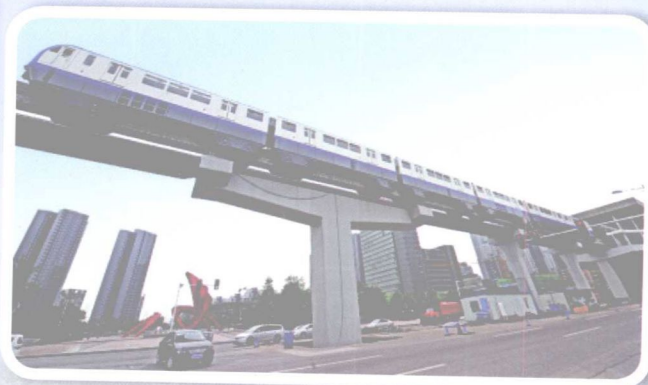
重庆轻轨3号线区间高架
