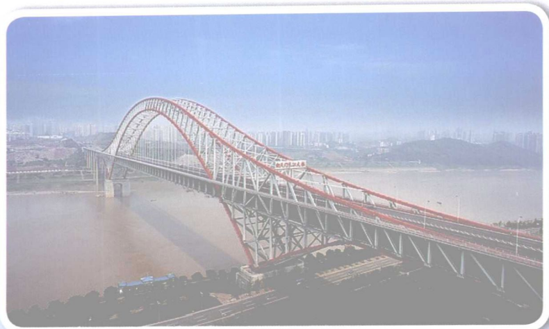
重庆朝天门长江大桥
