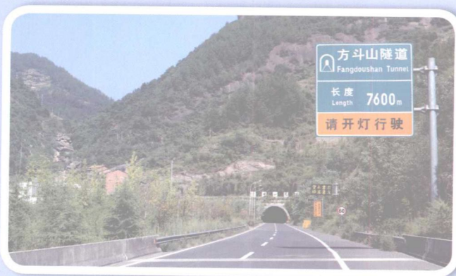
重庆方斗山隧道
