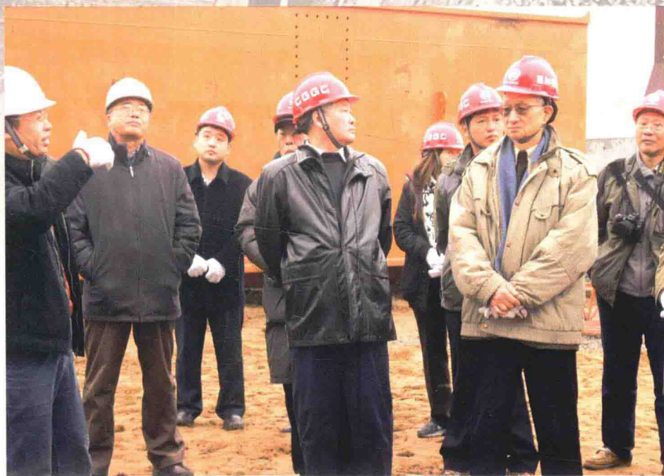
在水电建设工地指导工作
