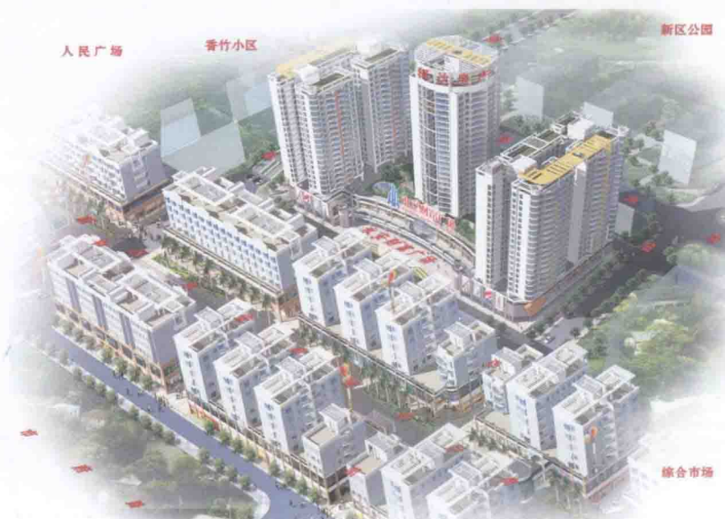
正在建设中的祁东新区永安商业步行街
