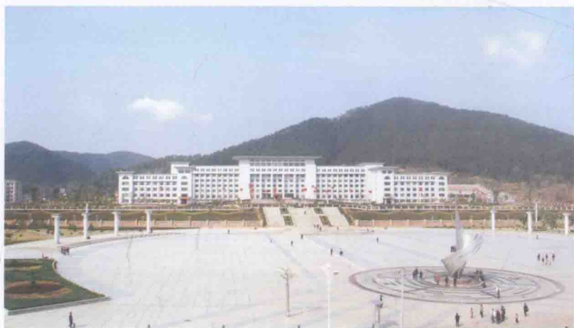
祁东县四大家办公大楼
