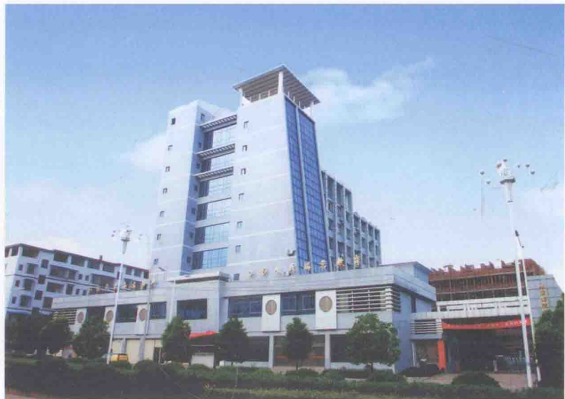
祁东县教育局办公大楼
