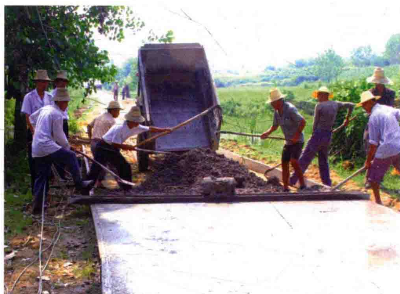
通村混凝土道路施工
