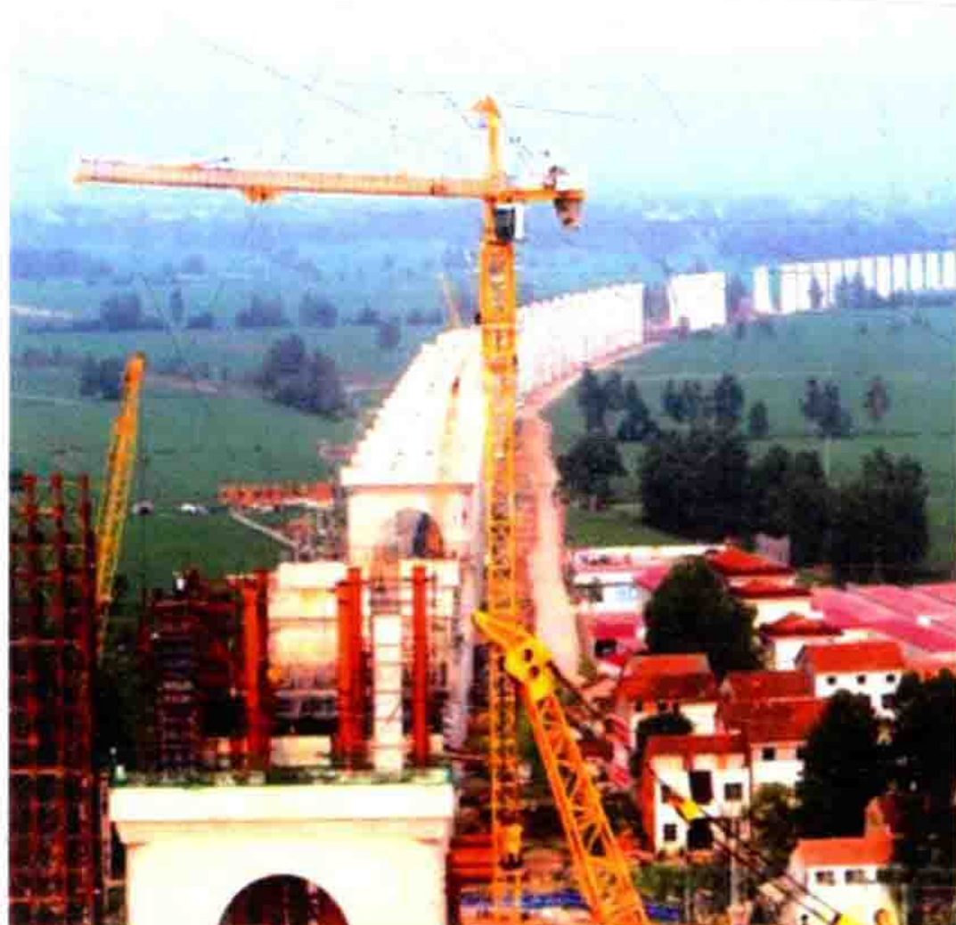
武冈城际铁路黄冈段施工
