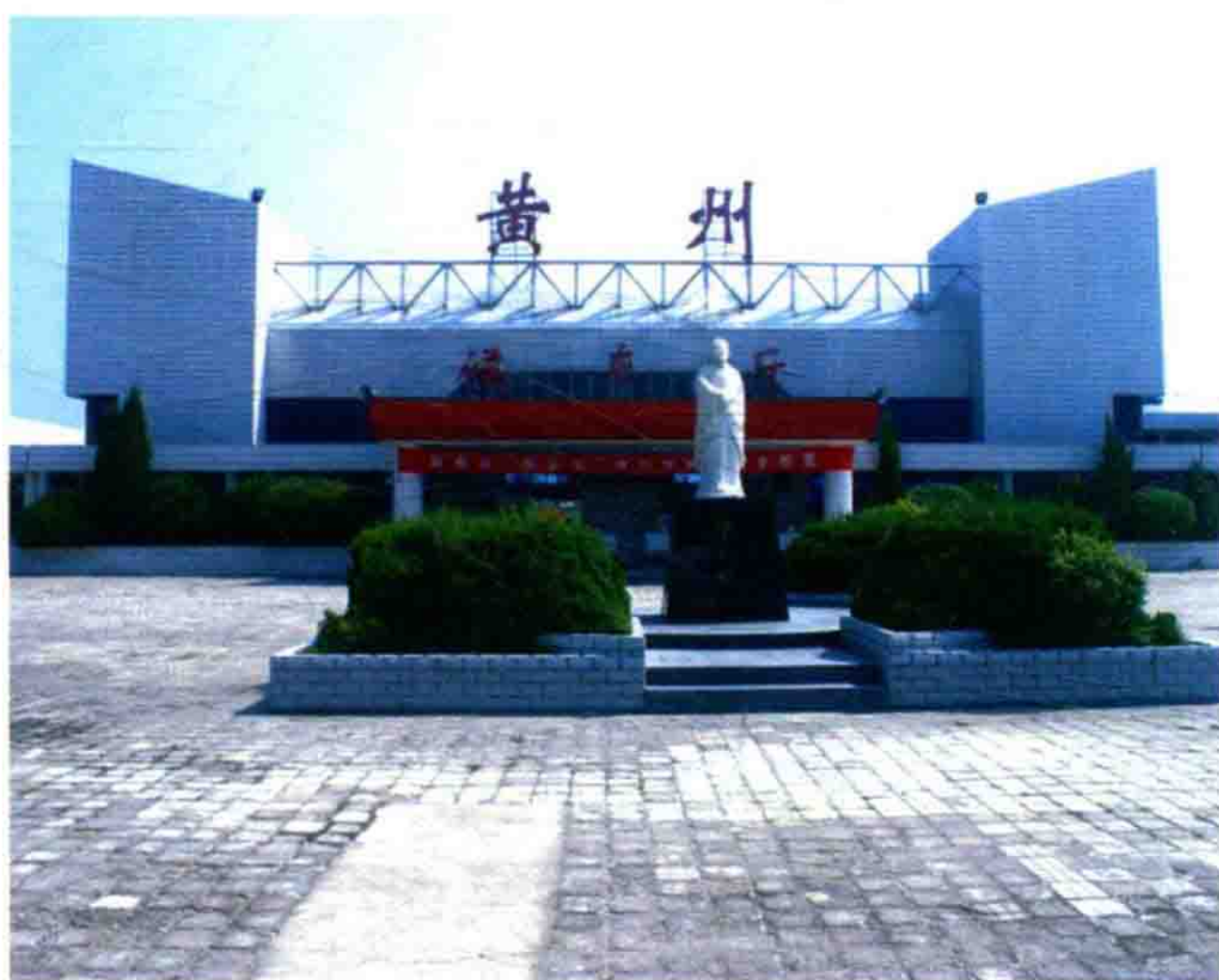
京九铁路黄州火车站
