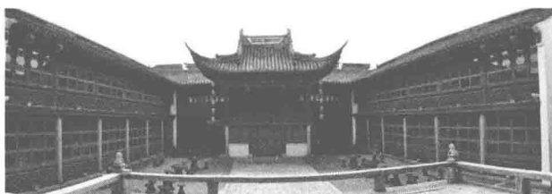
图 1-5 全晋会馆古戏台
