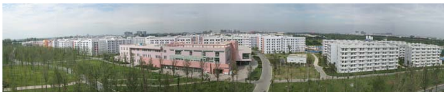
一期工程竣工后的新校区全景图
