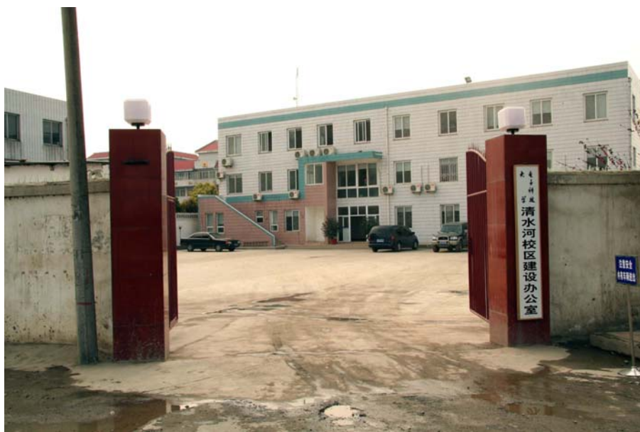
清水河校区建设办公室办公楼
