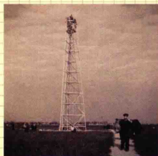
高钢觇标建造完工
