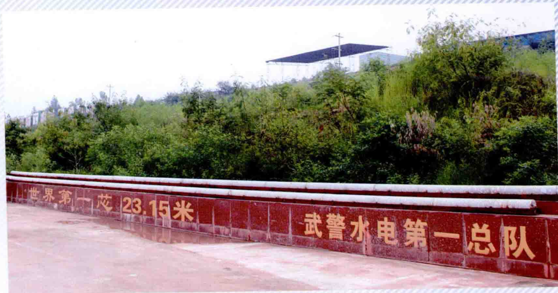
碾压混凝土坝 23.15m 长的芯样
