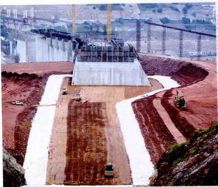
软接头部位施工
