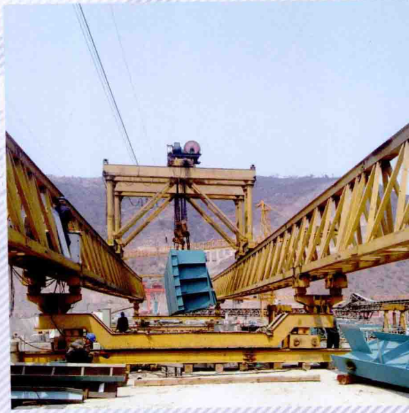
架桥机吊装钢闸门
