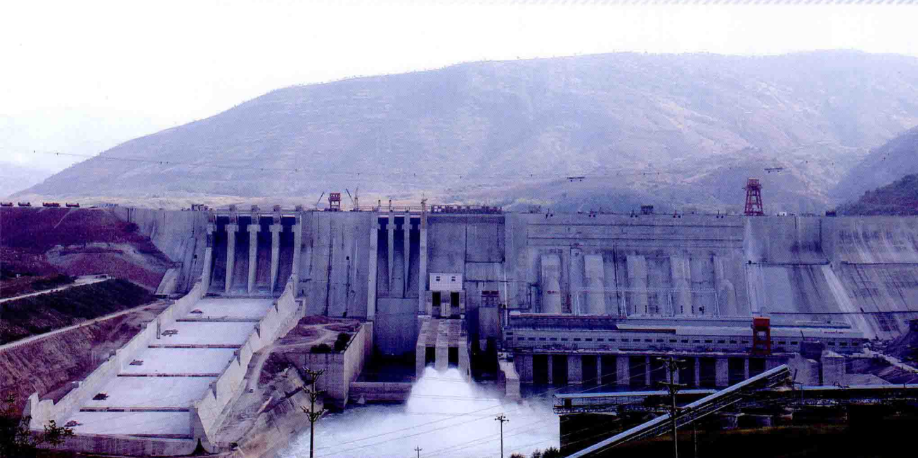
观音岩水电站下游侧全景
